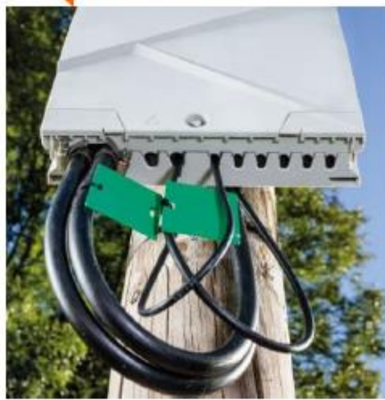
Point de Branchement Optique (PBO)
